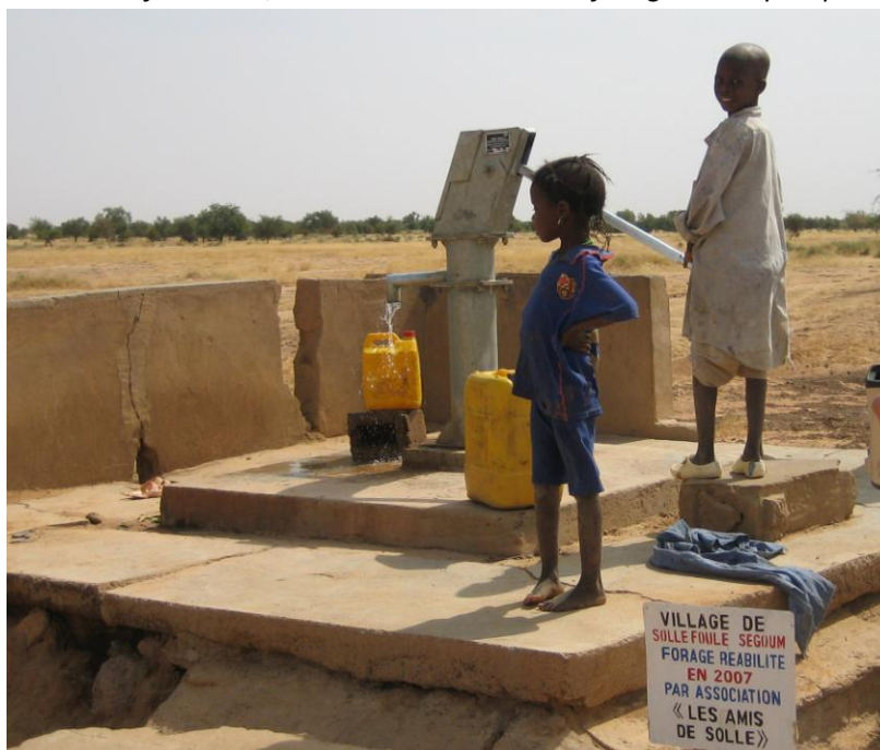
Forage réhabilité et maintenant en panne
