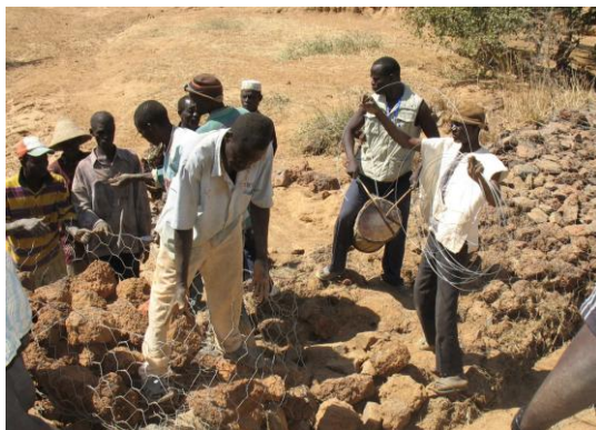
Construction de gabions
